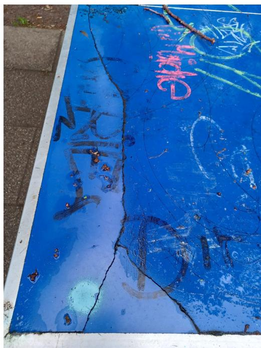
Der UBB stellt klar, dass die Platte offensichtlich durch Vandalismus beschädigt worden ist, nicht durch Temperaturschwankungen. Durch Versuche, die Platte mit Gewalt über die Ecken anzuheben, entstanden Brüche. Das ist auch sichtbar an einer Stelle, an der die Blechkante durch Untergreifen und Hochziehen nach oben gebogen wurde.
